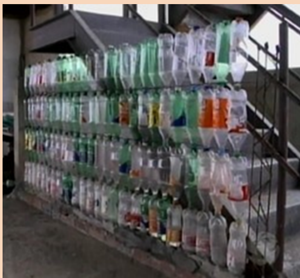
Foto 3: Botellas PET alineadas para formar pared – Fuente: G1 (2014).
