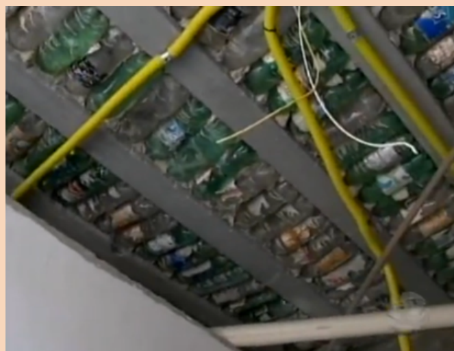
Foto 2: Botellas PET dispuestas en la losa del edificio – Fuente: G1 (2014).
