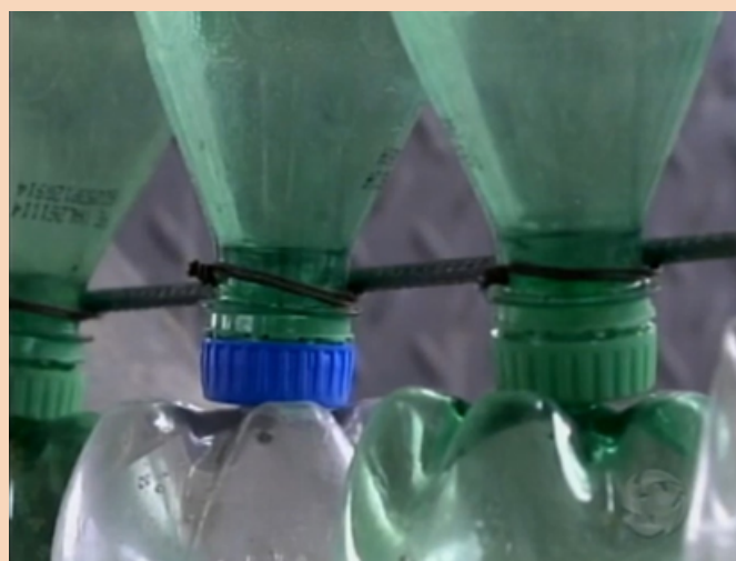
Foto 1: Unión de las botellas – Fuente: G1 (2014).
