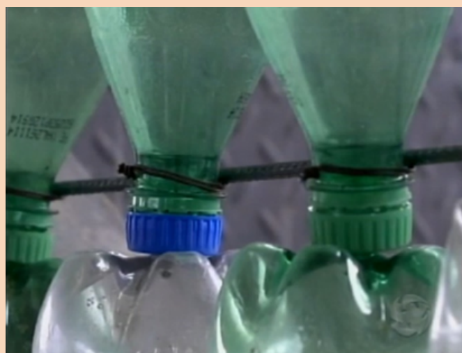
Foto 1: Unión de las botellas – Fuente: G1 (2014).
