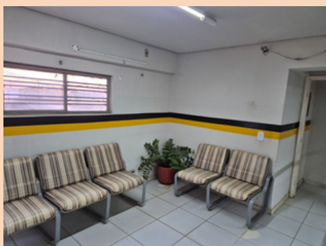
Foto 5 y 6 – En las fotografías se aprecia el acabado final de paredes y techos. Fuente: Elaboración propia (2025)
